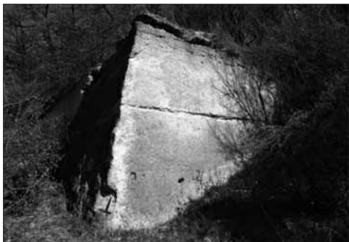
Obr. 3 Lom dvoch stien opracovaných špicákom. V strede a hore vidno väčšie polohy kameňa.
