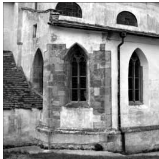
Obr. 16 Kostol sv. Kríža v Devíne. Záver gotickej bočnej lode. Armované rohy a sokel sú z devínskeho kameňa.
