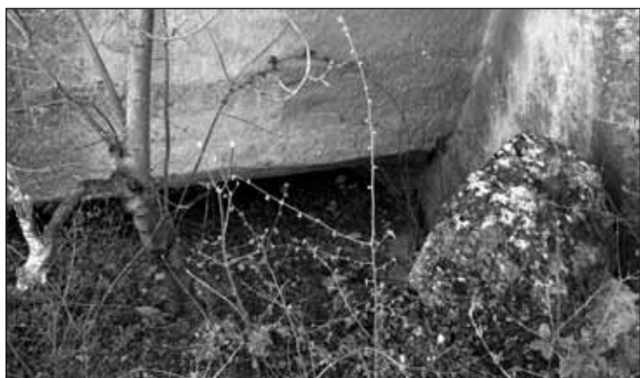
Obr. 5 Vrchol zasypanej komory. Steny sú opracované špicákom. Vpravo je odvalená časť steny.
