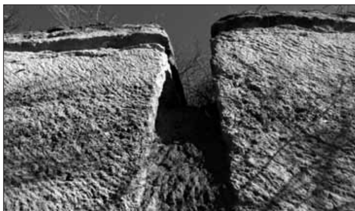
Obr. 6 Vertikálny kanál široký okolo 50 cm rozčleňuje stenu kameňolomu. Kanál aj steny sú opracované špicákom.
