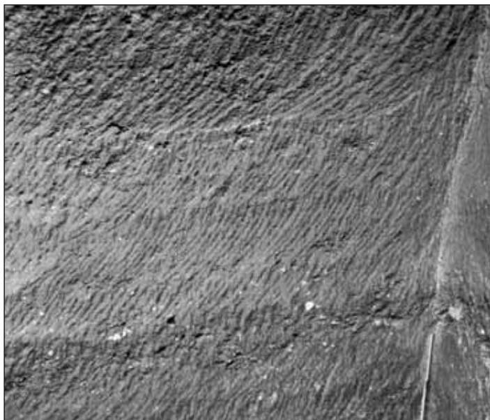
Obr. 7 Povrch steny bol opracovaný špicákom, ktorý zanechal za sebou sady pásov konkávnnych oblúkov.
